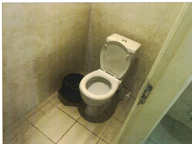
Фото № 10 – Санитарно-гигиенические помещения
