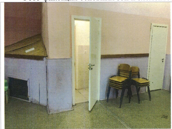
Фото № 8 – Санитарно-гигиенические помещения
