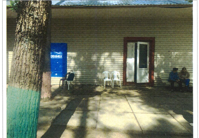
Фото № 4 – Главный вход. Входная площадка.
