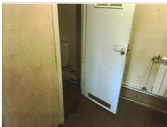
Фото № 10 – Санитарно-гигиенические помещения
