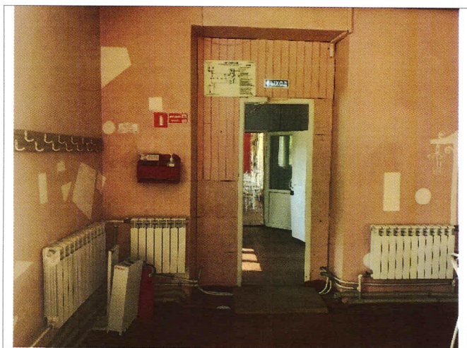
Фото № 7 – Пути движения внутри здания (двери).
